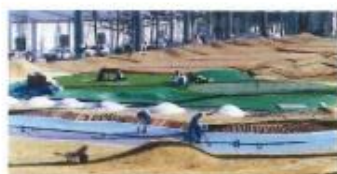
● 現地でのウレタン施工風景
